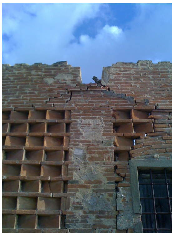
Foto n°7 Particolare fienile foto prima del crollo
