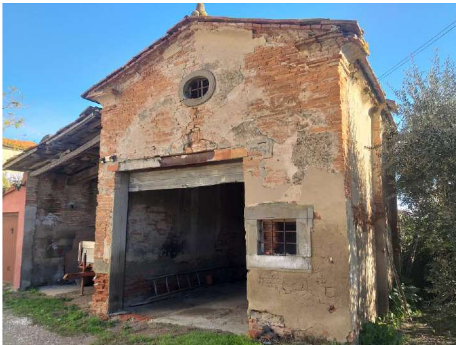
Località La Pieve. Edificio religioso di epoca moderna trasformato in garage.
