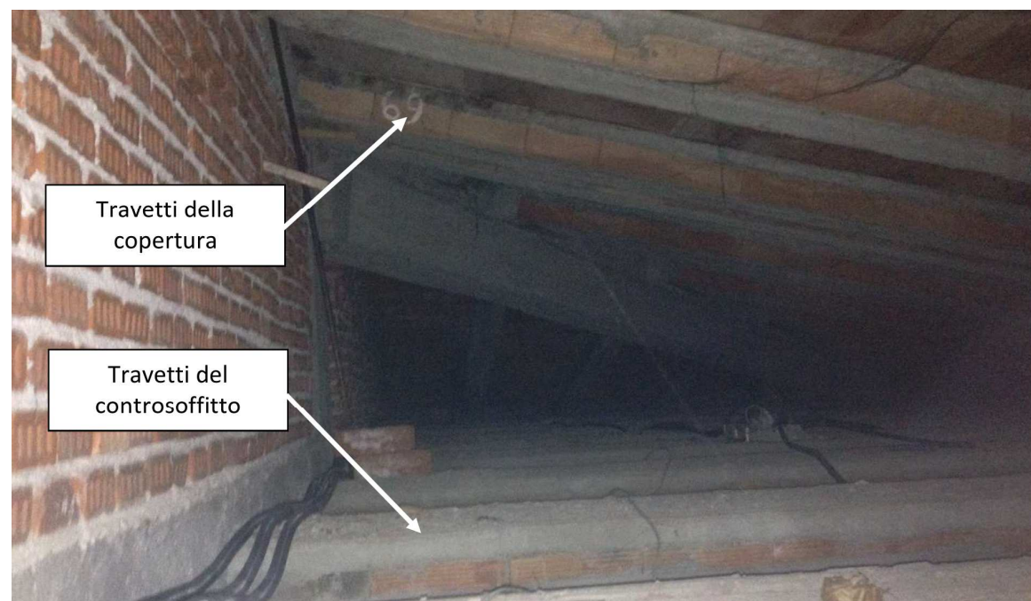
Solaio Copertura + Controsoffitto
